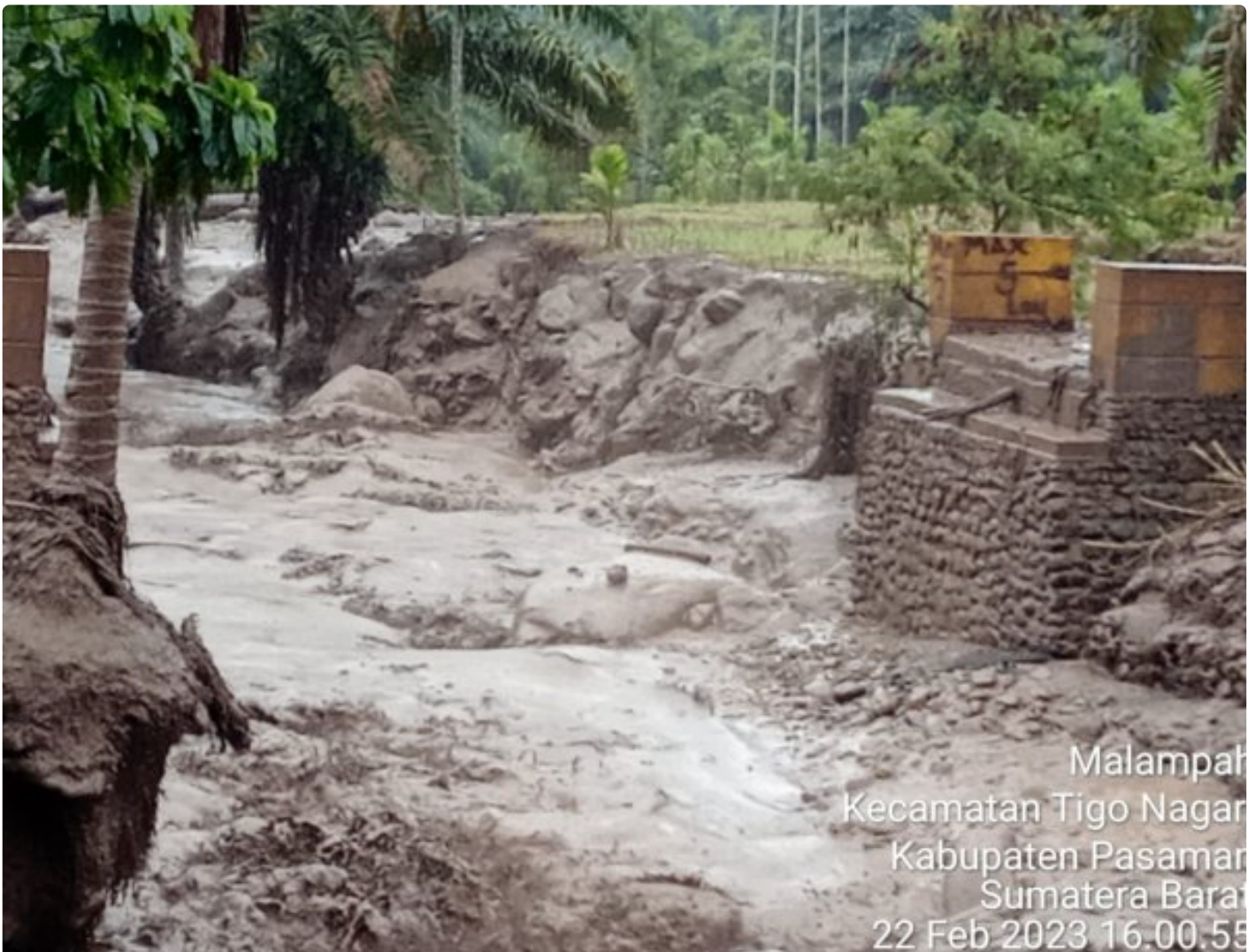
Banjir Malampah, Dua Jembatan Putus, Tiga Rumah Rusak, Belasan Hektar Sawah dan Kebun Tertimbun Lumpur.
